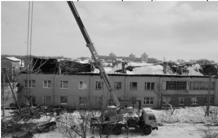
Рис. 2. Обрушення даху багатоквартирного житлового будинку, м. Чернігів
