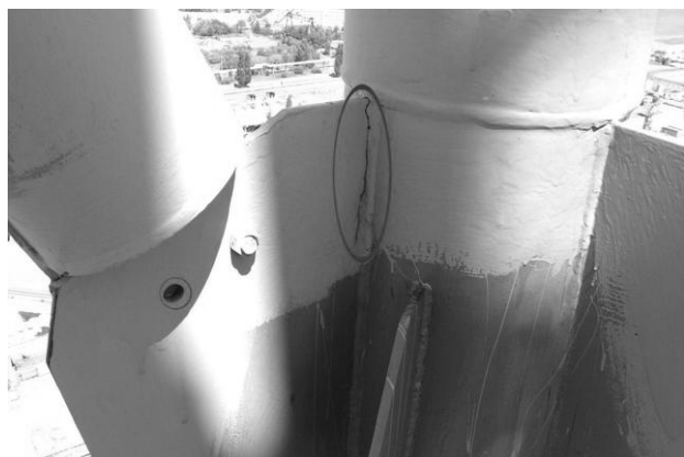
Рис. 7. Тріщини нової вентиляційної труби (НВТ-2) Чорнобильської АЕС
