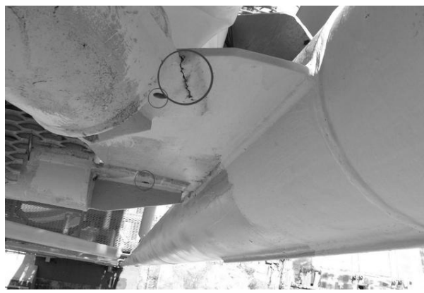
Рис. 7. Тріщини нової вентиляційної труби (НВТ-2) Чорнобильської АЕС
