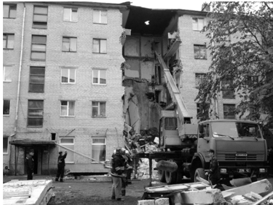
Рис. 6. Обрушення п'ятиповерхового будинку, м. Луцьк
